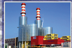
Porto CORSINI - hrsg for Power Plant - Italy
