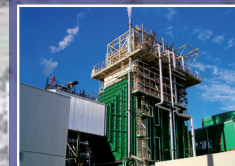
TAVAZZANO - HRSG for Power Plant - Italy
